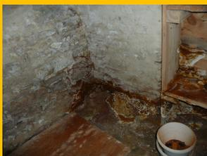
Puis la mэрule fructifie et devient visible. En général, c'est trop tard. Le bois est attaqué et déstructuré. La structure même du bâtiment peut être menacée
