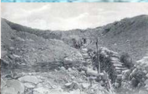
Tranchée de Flirey
