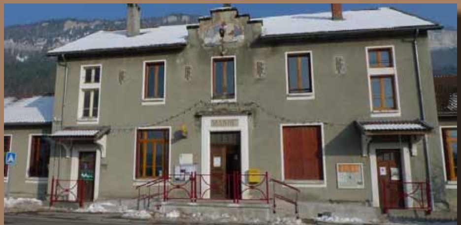
Les rampes définitives et mains-courantes ont été posées en mars.
