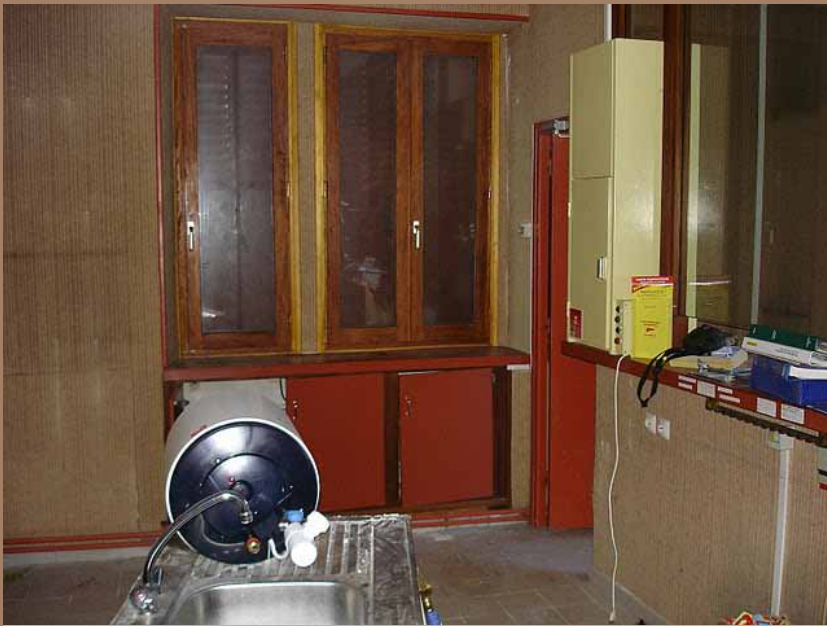
L'ancien bureau de Poste en chantier avec le guichet...
